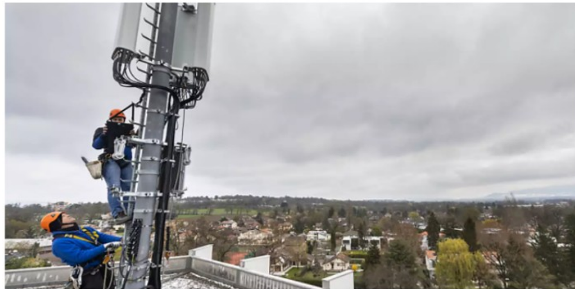
Montage einer 5G-Antenne in Chêne-Bougeries am 5. April im Kanton Genf. - sda - KEYSTONE/MARTIAL TREZZINI
